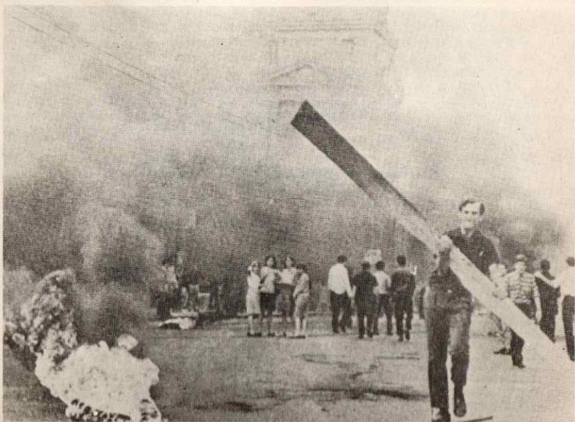
Destrucción, incendios y vandalismo en las calles, originados en los centros de estudio.
